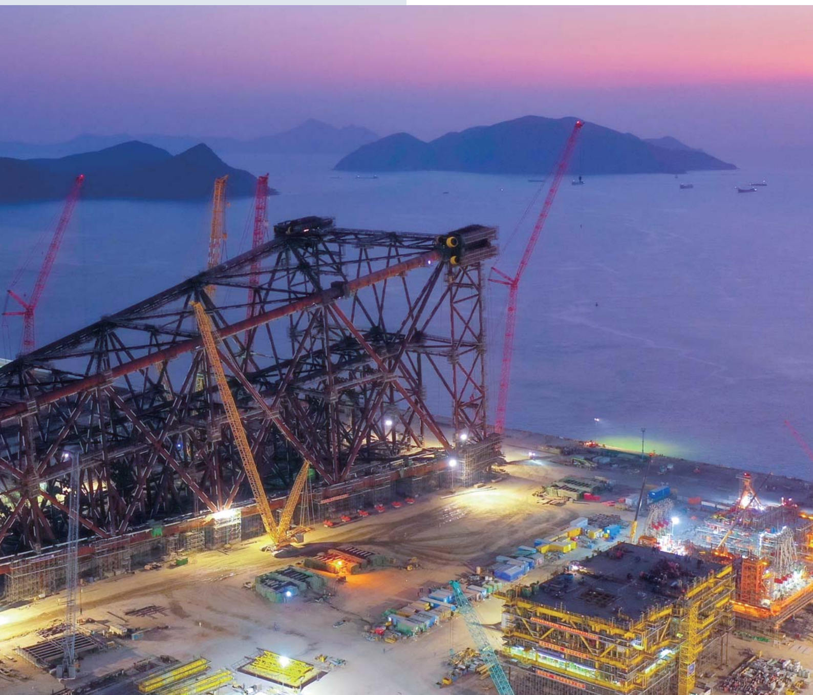
▼ 陆丰油田群区域工程项目 海基一号建造现场
