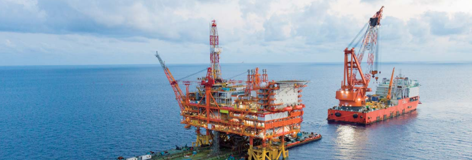
▲ 恩平油田群区域开发项目 浮托现场
