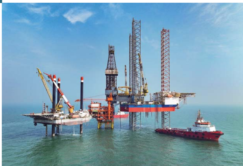
▶ 垦利 6-1 油田 KL5-1、5-2、6-1 区块开发项目 WHPG 平台
