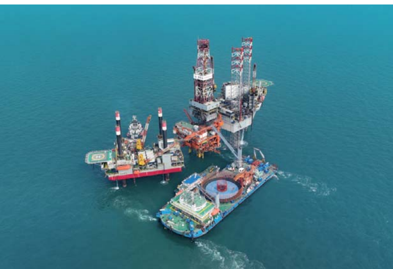
◀ 垦利 6-1 油田 KL5-1、5-2、6-1 区块开发项目 WHPF 平台
