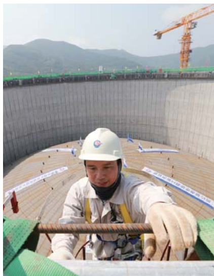
▲ 储罐气压升顶过程中，施工人员前往监测
