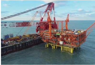
▲ 渤中 29-6 油田开发项目 组块海上安装
