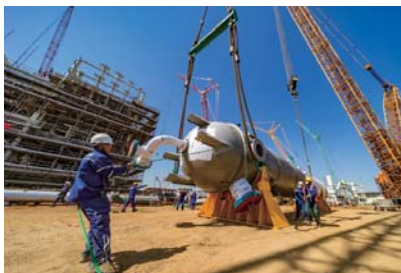
◀ 施工人员正在合力准备吊装作业
