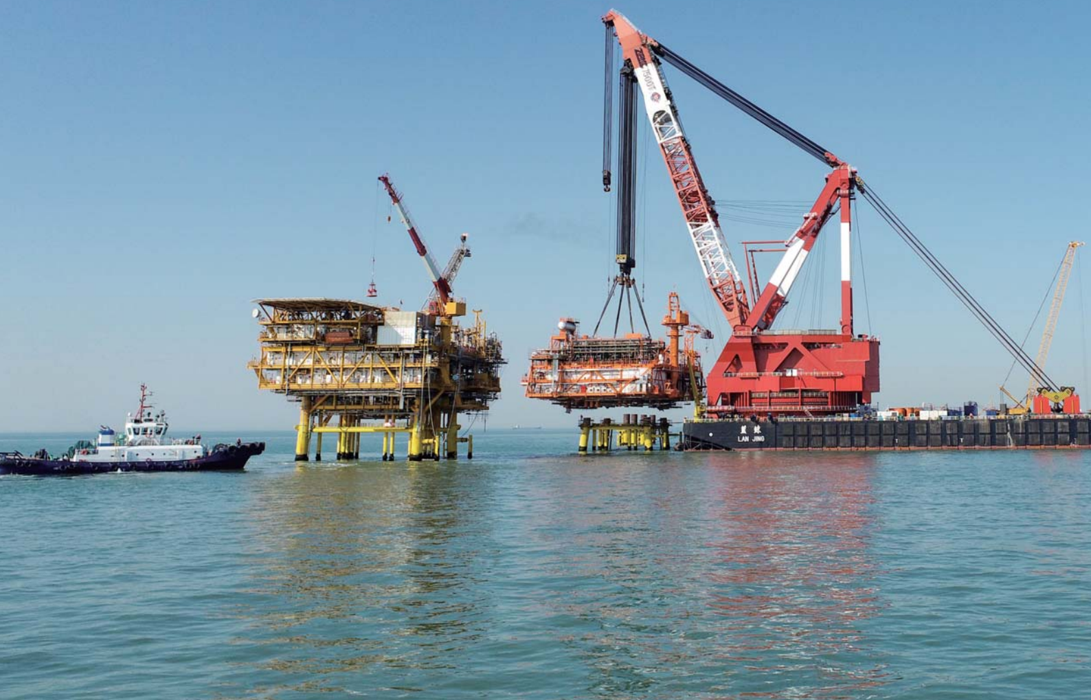
▲ 渤中 19-6 凝析气田 I 期开发项目 海上安装
