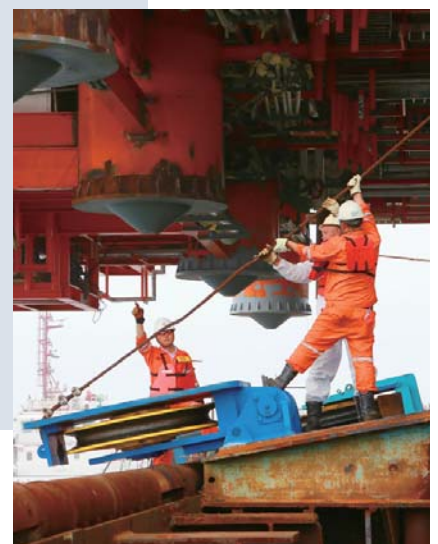
▶ 海上安装现场
