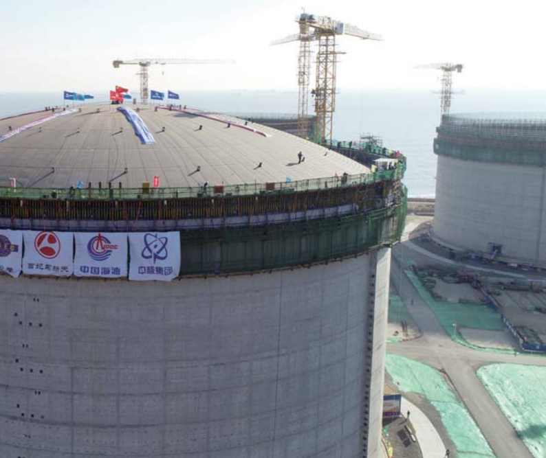
◀ 唐山 LNG 项目接收站二期工程项目
