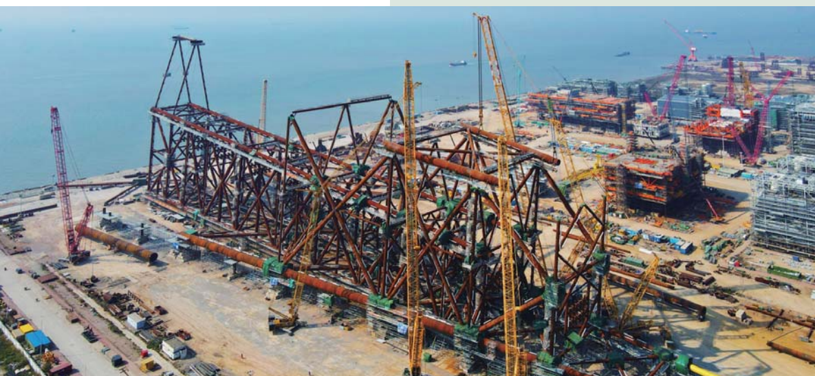
▼ 流花 11-1/4-1 二次开发项目 导管架陆地建造
