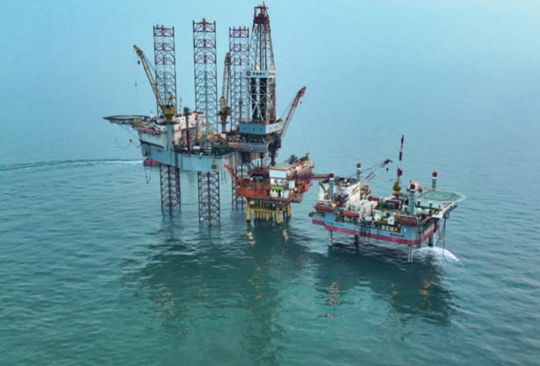
◀ 垦利 6-1 油田 KL5-1、5-2、6-1 区块开发项目 WHPD 平台
